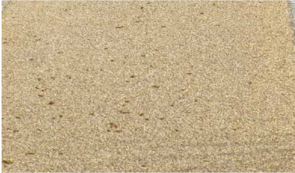
Zandkleurig asfalt zonder wit bitumen, met ingewalste lichte toeslag Wandelpad (skatebaar, glad), kleur asfalt nader te bepalen en ingewalste toeslag nader onderzoek leveranciers en bemonstering noodzakelijk
