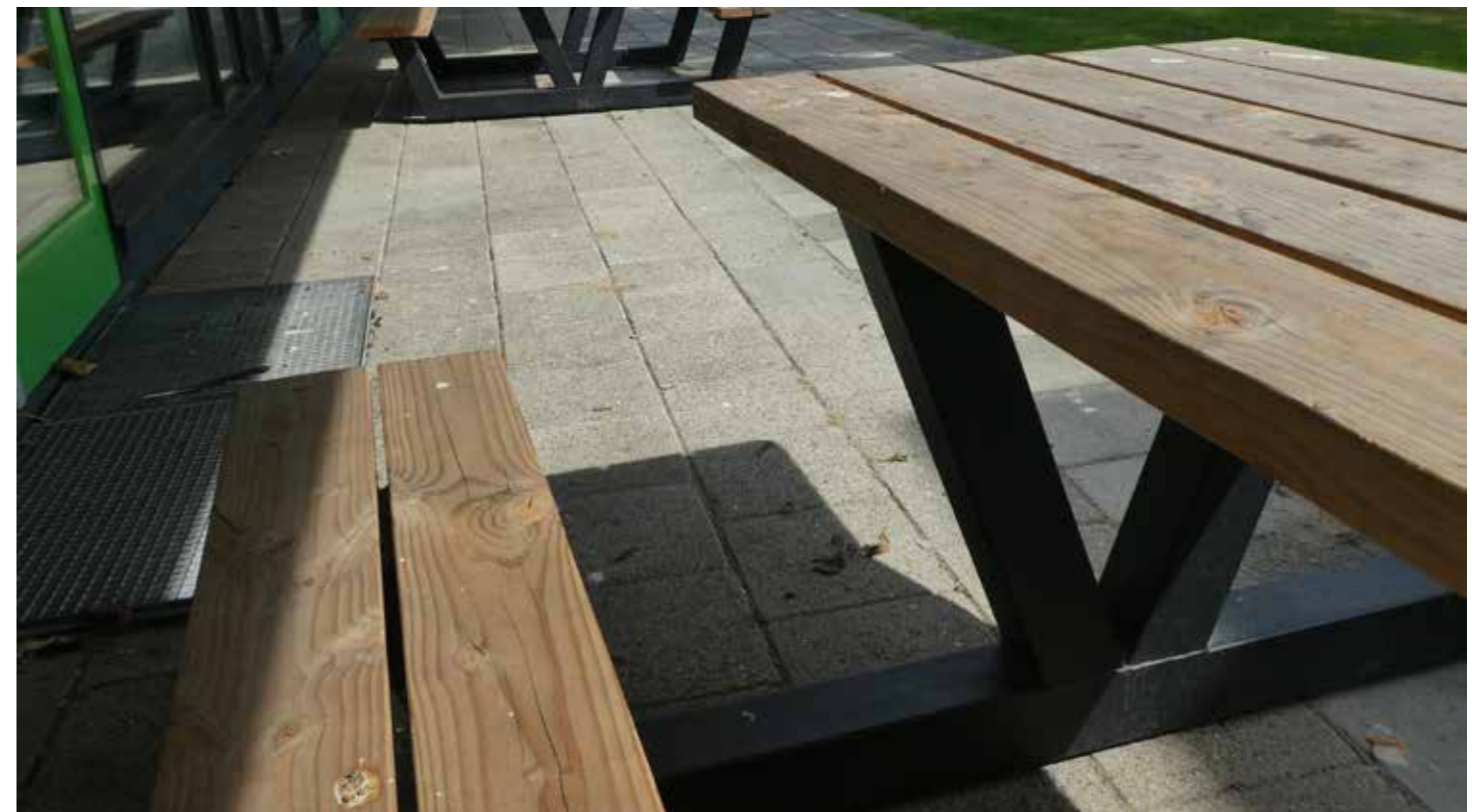
Robuuste natuurbank variant 2 (minder hout benodigd), zonder leuning in speelbos. Regenwater kan afstromen van het zitvlak.
